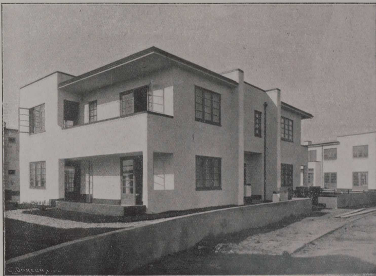
Construites en béton granuleux (Korrelbeton)
